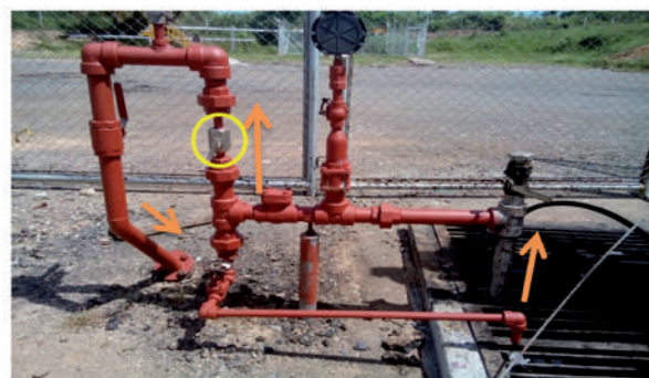
Figura 7. Red de recolección de gas de anulares del pozo CIRA-M luego de la instalación de la válvula choque
