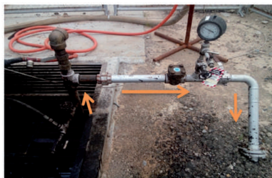
→ Dirección del flujo de gas de anular
